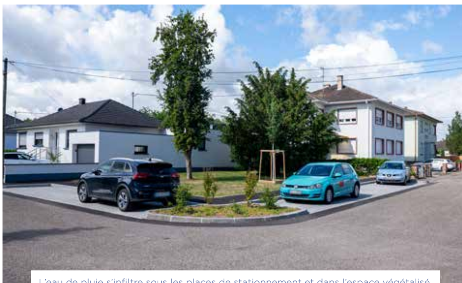
L'eau de pluie s'infiltré sous les places de stationnement et dans l'espace végétalisé.
