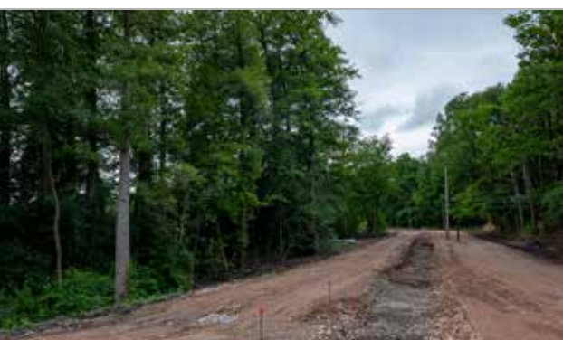
D'une durée de trois mois, les travaux permettront de compléter le réseau des pistes cyclables de Haguenau.
